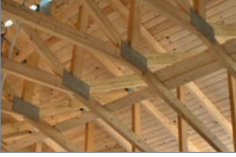
Şekil 6. 7. Farklı çatı birleşim elemanları
